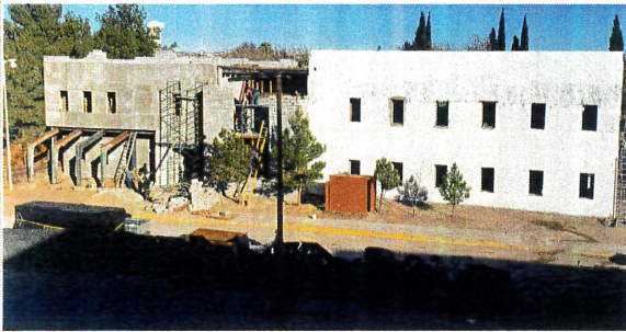
F1: Fachada principal
