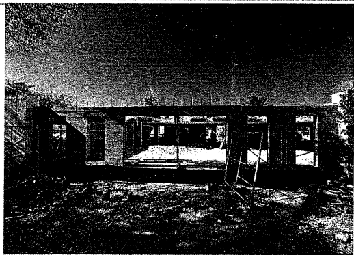
F1 Fachada principal
