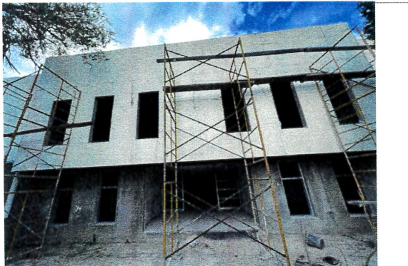
F1: Fachada principal
