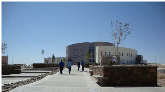
Edificio A, DMCU. FAM 2009.
