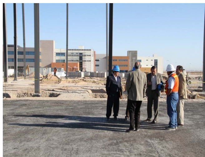
El Rector y los directores generales de Servicios Administrativos y de Planeación supervisan la construcción del Edificio D en la División Multidisciplinaria Ciudad Universitaria.
