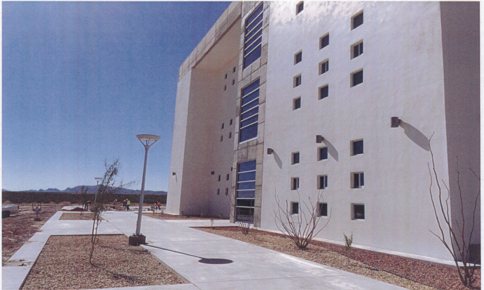
Construcción de Edificio Multifuncional D4.
