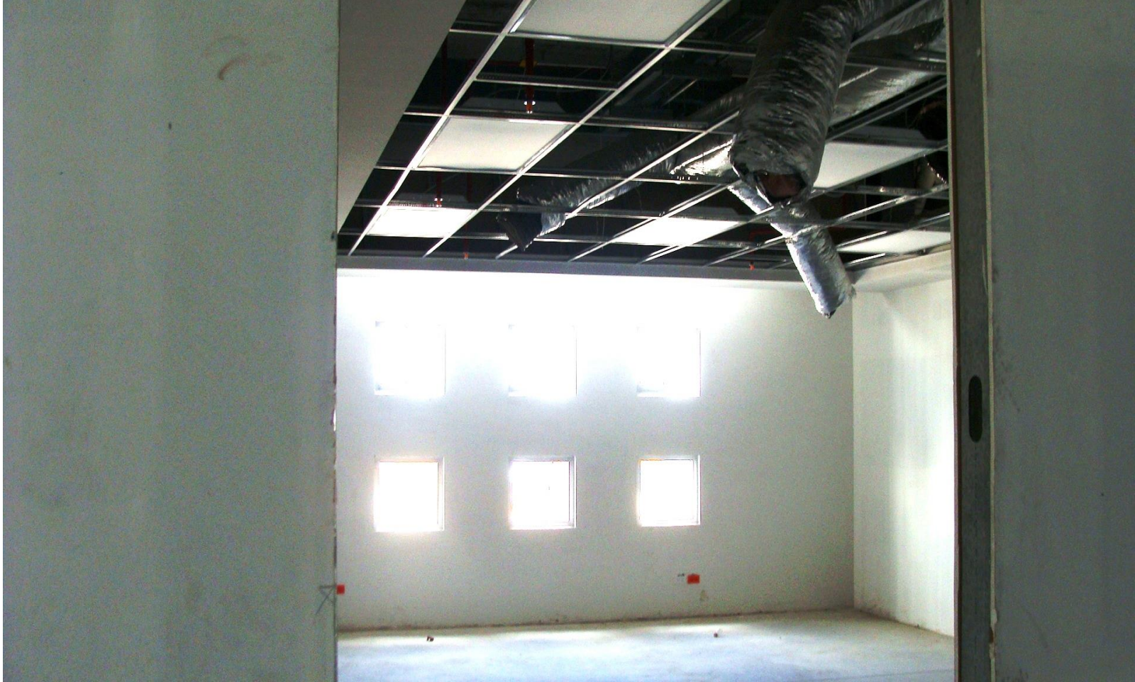
Construcción de Edificio Multifuncional D4.
