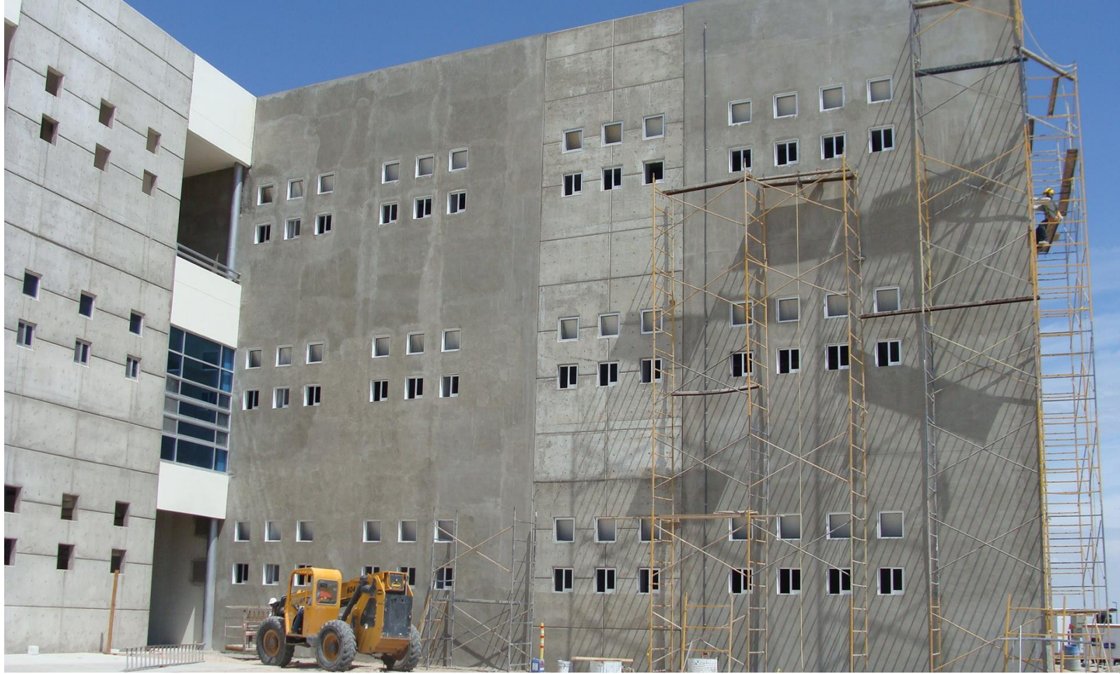
Construcción de Edificio Multifuncional D4.
