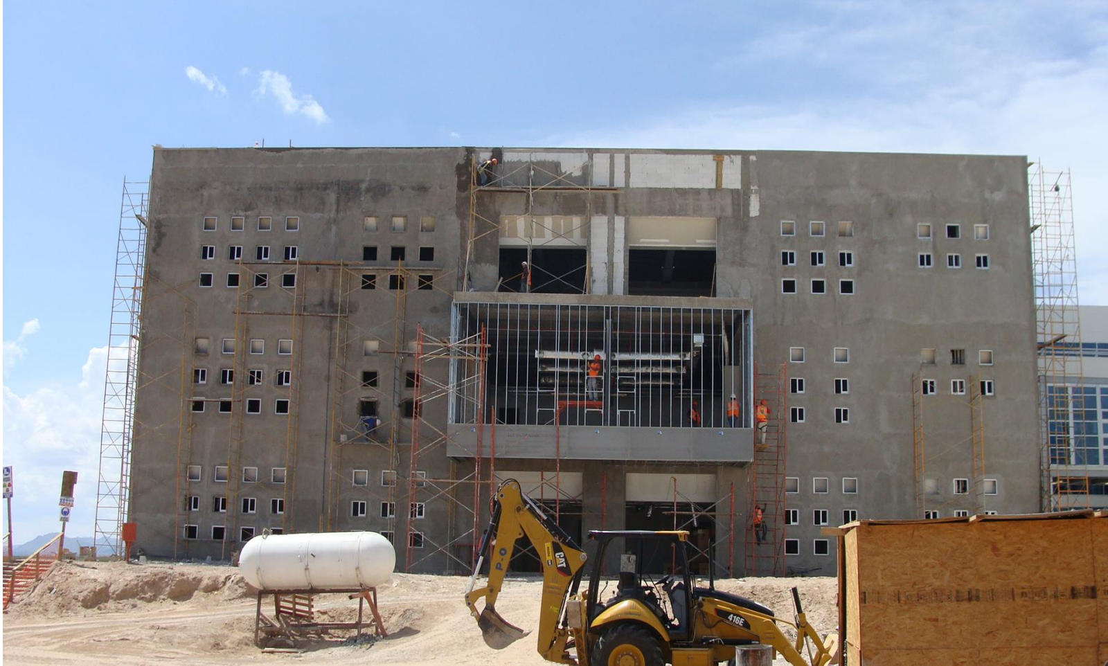
Construcción de Edificio Multifuncional D4.
