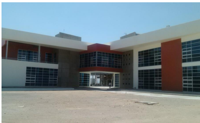
Fotografía 8.- Panorámica del Edificio D2 (laboratorios) en Ciudad Universitaria
