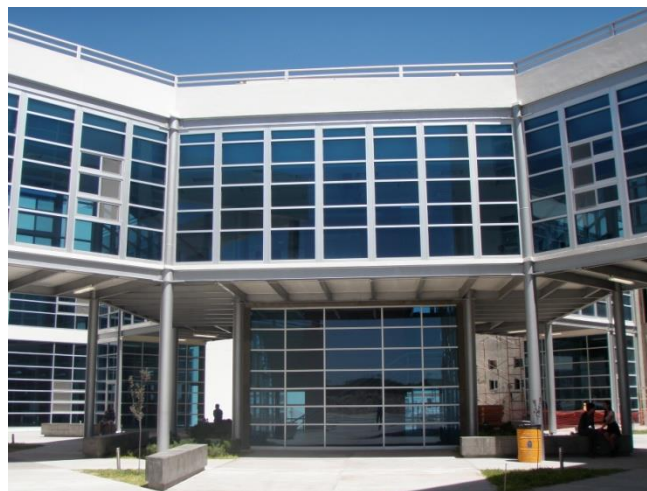
Fotografía 6.- Fotografía del núcleo del complejo de laboratorios en Ciudad Universitaria.
