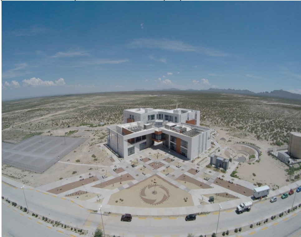
Edificio CUIPE en la DMCU
