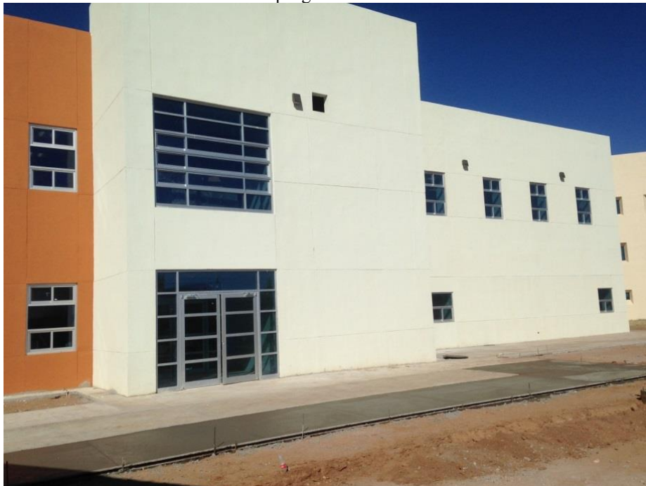
Edificio De en DMNCG
