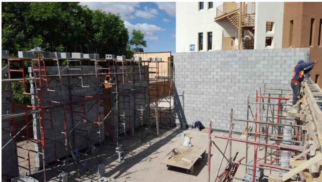
Edificio de talleres del IADA
