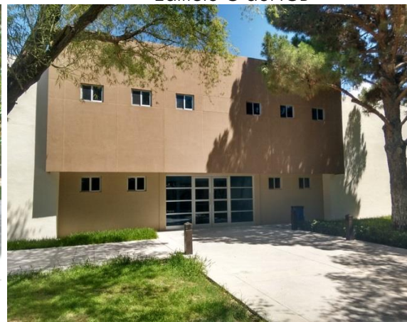
Edificio C del IIT
