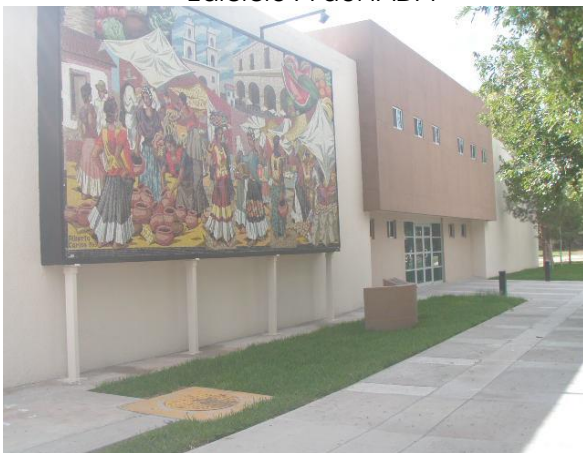
Edificio B del ICSA
