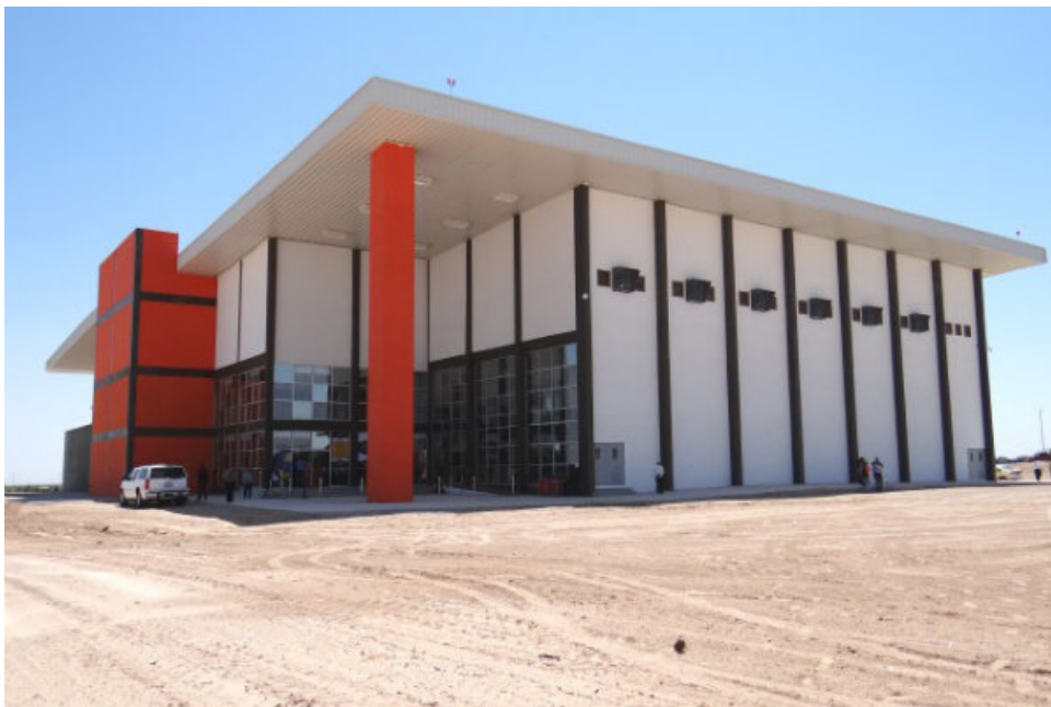
Gimnasio de Usos Múltiples DMCU.
