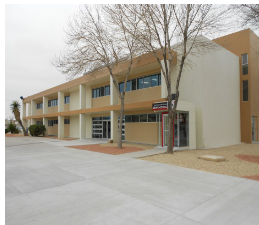
Edificio C del ICB.
