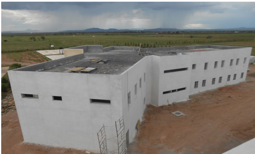
Edificio multifuncional "E" en la DMNCG.
